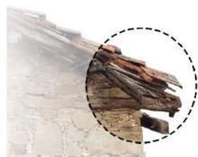
Κροδώματα: Η διαμόρφωση της άκρης του δώματος γίνεται με μια προεξέχουσα σειρά από ξύλινα στοιχεία για την προστασία της τοιχοποιίας από το νερό.
