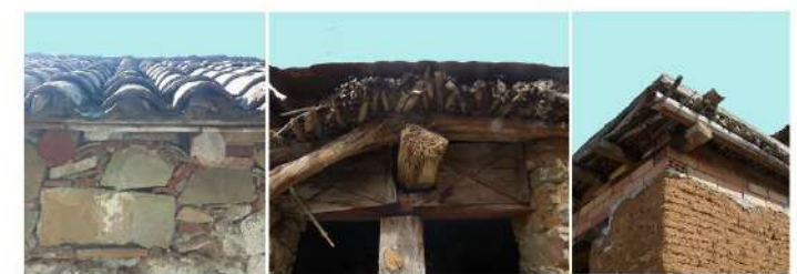
Οροφές- στέγες και δώματα: Στις ορεινές περιοχές υπάρχουν μονοκλιείς σε μικρά κτίσματα ή δικλιείς στέγες σε μεγαλύτερα, με κεραμίδια (με κλίση). Παρ' όλα αυτά, υπάρχουν και τα δώματα ως τρόπος στέγασης κατοικιών ή και δωματιών.
